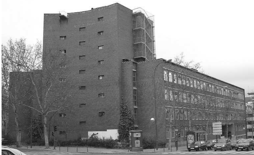
Edificio del arquitecto Miguel Fisac, sede original del CIB en la calle Velázquez de Madrid.
