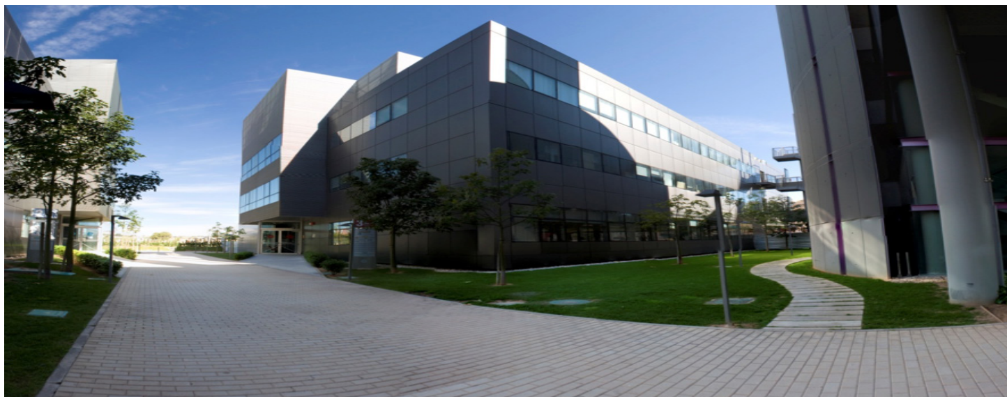
Edificio CUE3 del Parque Científico de la Universidad de Valencia
